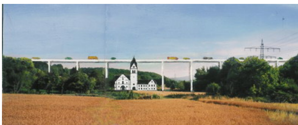
Fotomontage der Brücke über dem Liederbachtal (4-spurig, 32 m hoch, 438 m lang; zum Größenvergleich einmontiert: Kloster Hornau)
