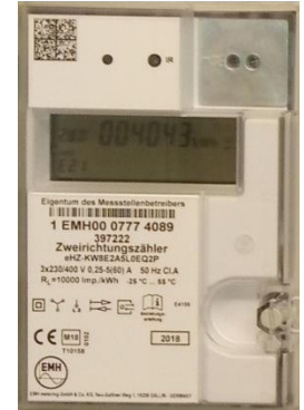
Stromzähler / Moderne Messeinrichtung
