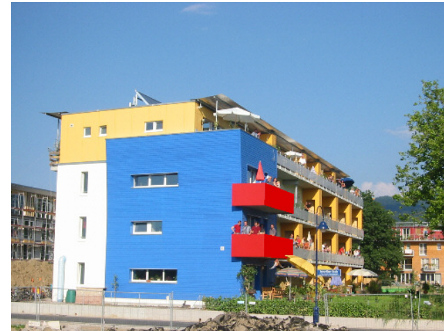
Mehrfamilienhaus in Stuttgart Vauban
