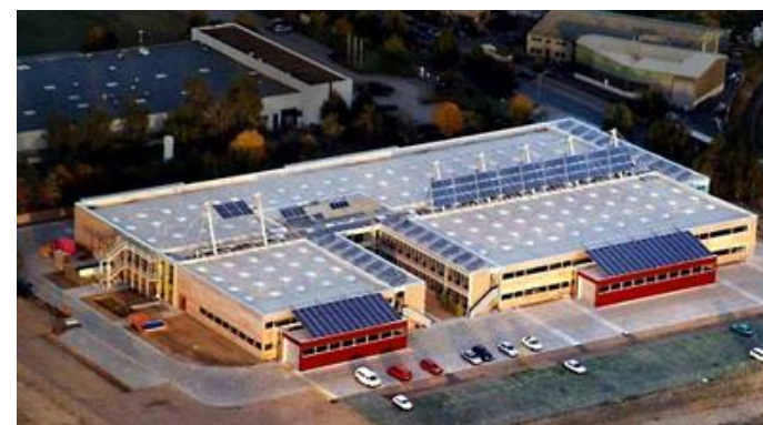
Fabrikgebäude von Solvis, Braunschweig
