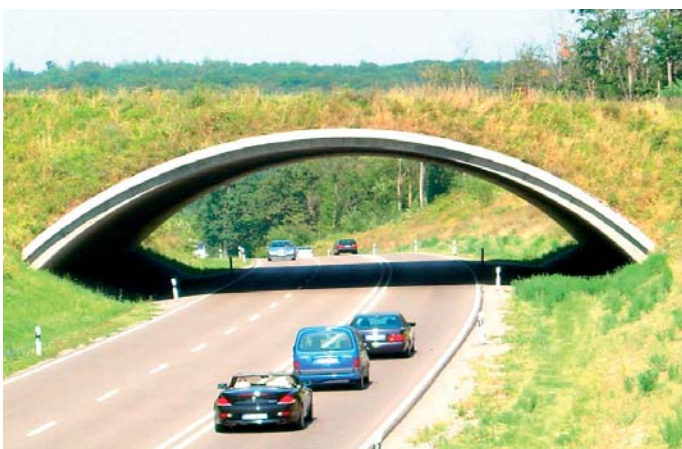
Grünbrücke über die B464
