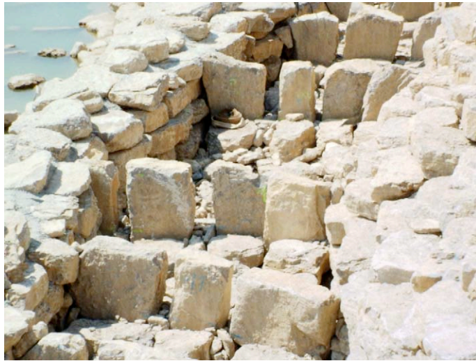
Abb. 7: Einer von 3 Fischpässen am neuen Kraftwerk Rheinfeldern noch ohne Wasser. Gut erkennbar, die Schlitze bis zum Boden und Steinbedeckung der Sohle
