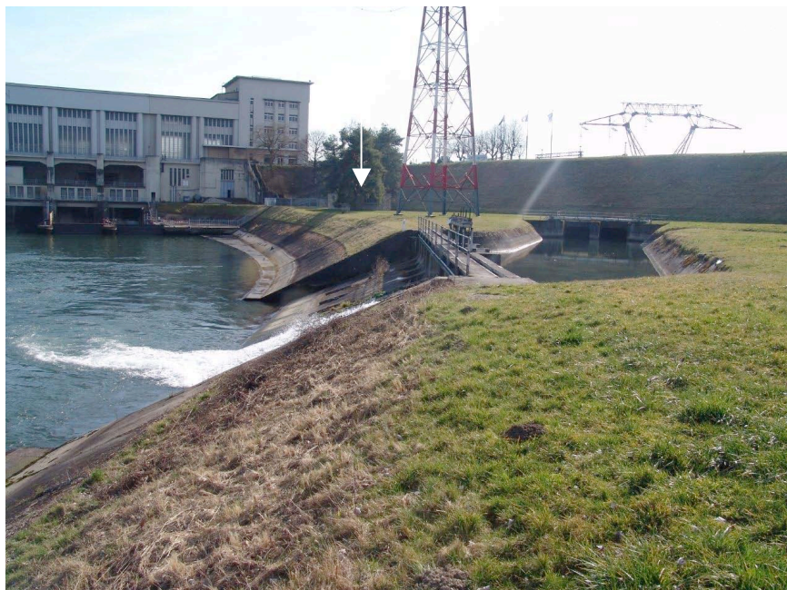
Abb. 4: Mündung des Abzugsgraben mit Absturz in den elsässischen Kanal. An dieser Stelle ist ein Verbindungsgewässer geplant (vgl. Abb. 5).
