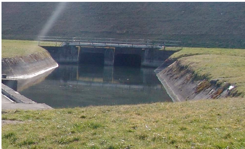
Abb. 6: 200 m lange Verdolung (Tunnel)
