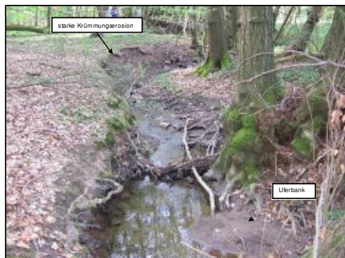
Bild 1881: Uferbank und starke Krümmungserosion
