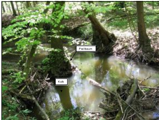
Bild 1954: Pfalbaum, Kolk und Treibholzverklausung (Bild in Flierichtung)
